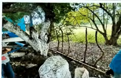
Foto 8: TRABAJOS EXTERIORES Sustitucion de muro de malla en mal estado por muro de block y malla cal 12.
