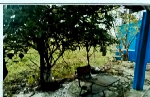
Foto 6: TRABAJOS EXTERIORES Sustitucion de muro de malla en pesimas condiciones por muro de block.
