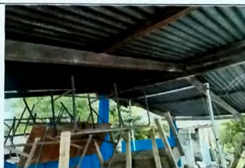
Foto 12: MODULO A Vista de cubierta de lamina de zinc con estructura de madera.
