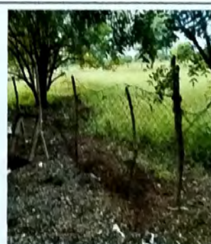
Foto 4: TRABAJOS EXTERIORES Sustitucion de muro de malla en pesimas condiciones por muro de block.
