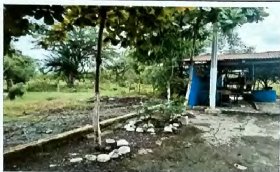
Foto 7: . TRABAJOS EXTERIORES Sustitucion de muro de malla en mal estado por muro de block y malla cal 12.
