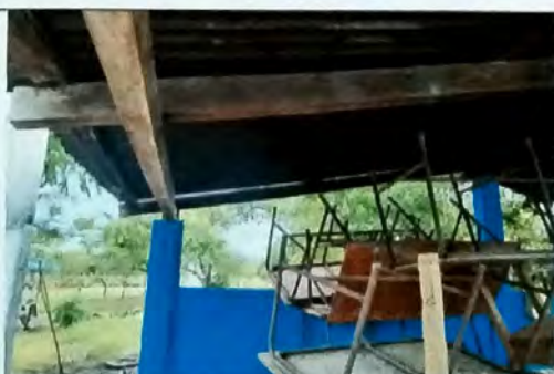
Foto 11: MODULO A Vista de cubierta de lamina de zinc con estructura de madera.
