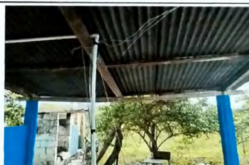
Foto 10: MODULO A Vista de cubierta de lamina de zinc con estructura de madera.
