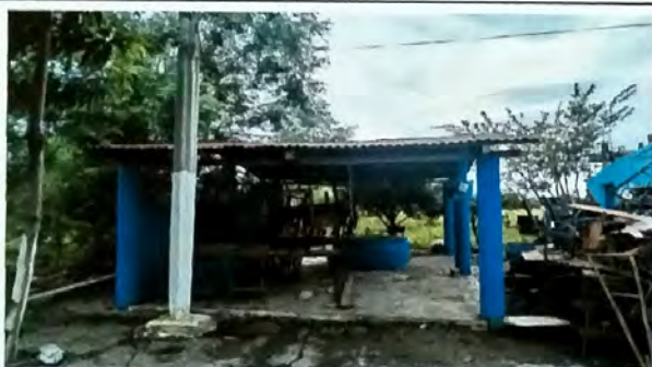
Foto 9: MODULO A Cocina , cambio de estructura de madera por estructura de metal y cambio de lamina de zinc por lamina troquelada
